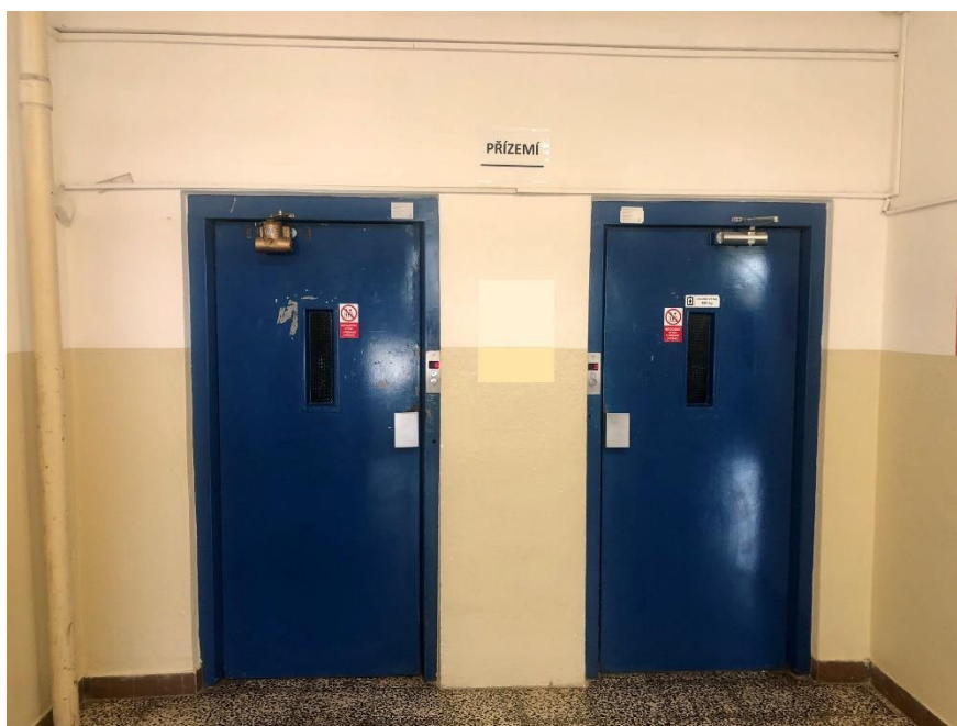
Aktuální stav – stanoviště přízemí
